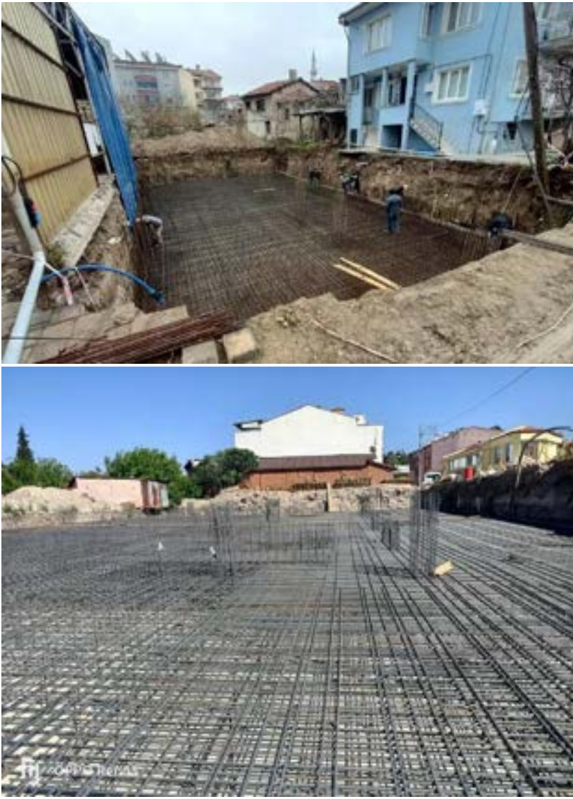
Devam Eden İnşaatların Temel Donatı Kontrol Örnekleri
